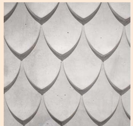
Aufprofilierungen und Betonkosmetik
