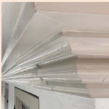
Mit Ölfarbe gestrichene Dachuntersichten
