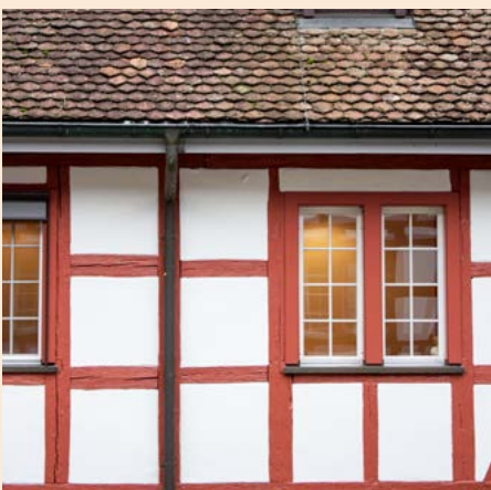
Mit roter Ölfarbe gestrichener Riegel
