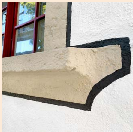
Scharrierter Naturstein, gestrichen mit Organosilikatfarbe und dazugehörigem, umlaufendem Filet- bzw. Begrenzungsstreifen
